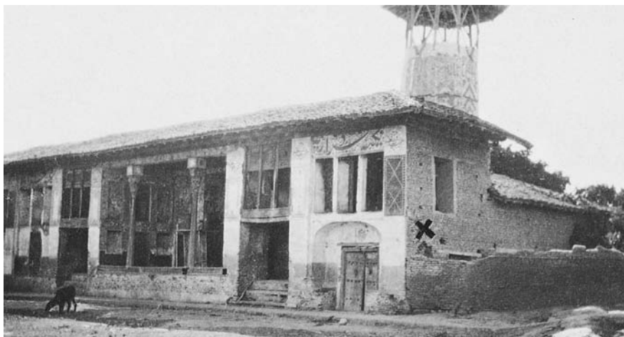
قسمت دیواری که خراب کردند با علامت X مشخص شده
