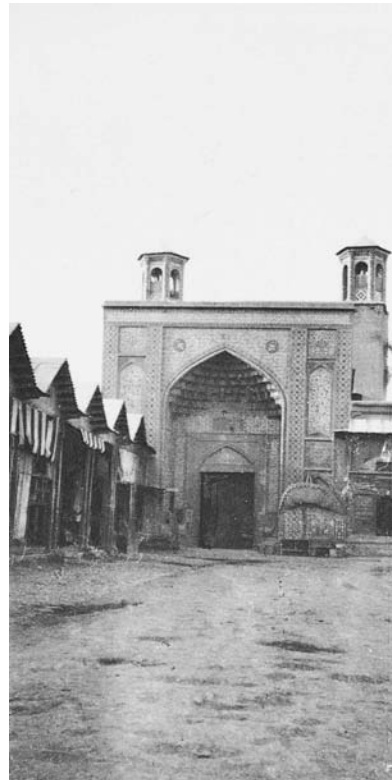
درب ورودی مسجد
